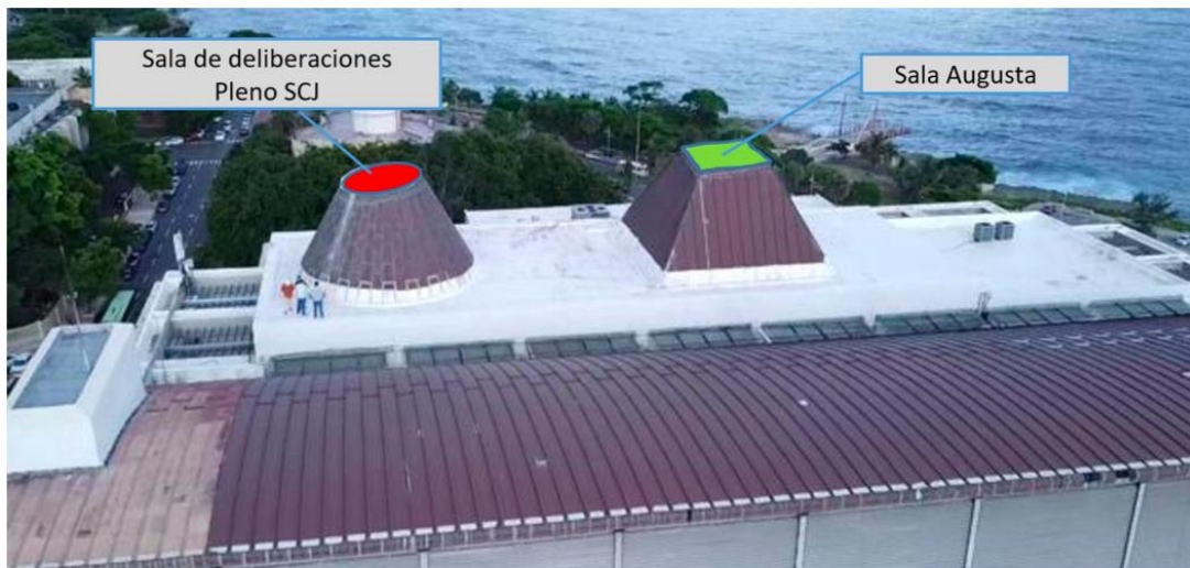
Ilustración 1 Vista aérea de las cúpulas objeto de la contratación, encerradas en círculo amarillo.
