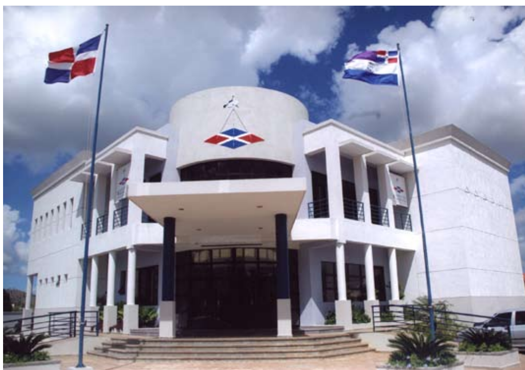
Edificio que aloja las oficinas del Tribunal de Tierras y el Registro de Títulos, en Higüey.
