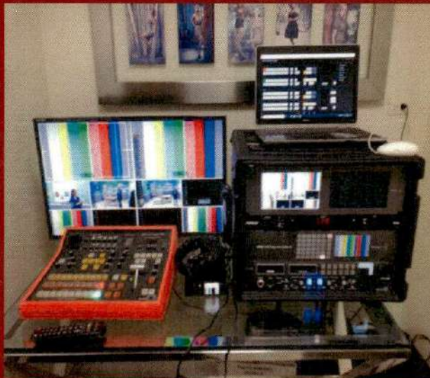
Switsher para Circuito Cerrado
