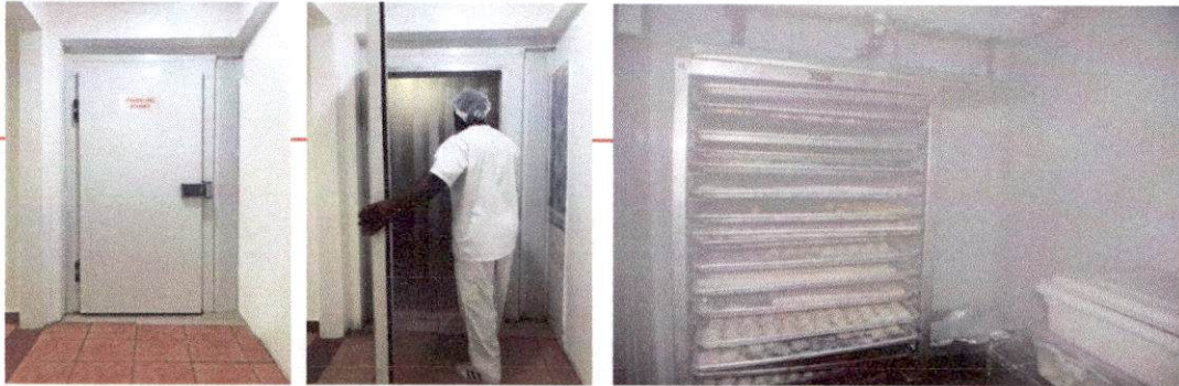
CUARTO FRÍO BOLLERÍA
