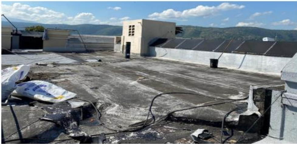
Lote 8 – Impermeabilización de techo del Palacio de Justicia de La Vega.
