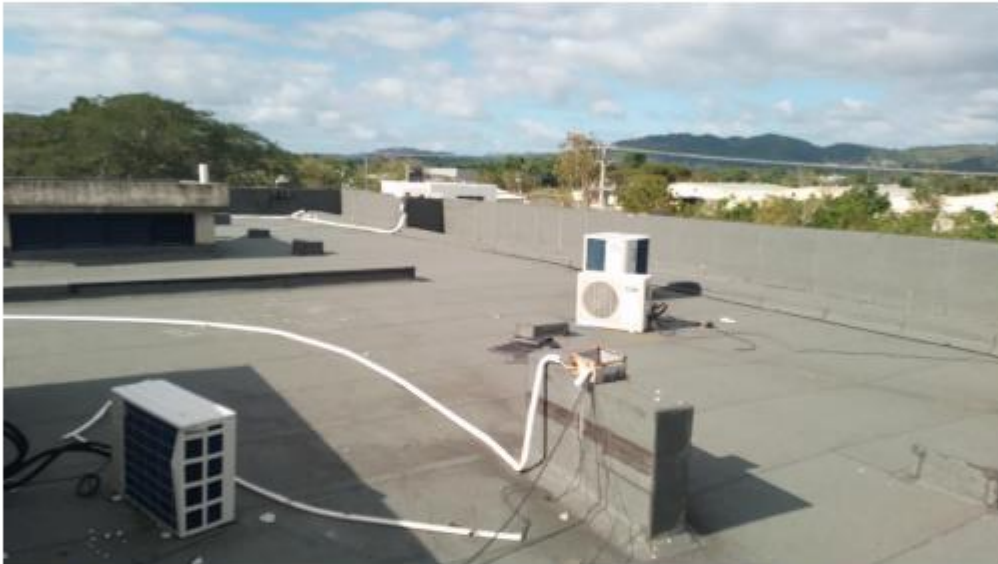
Lote 2 – Impermeabilización de techos Palacio de Justicia de Hato Mayor.
