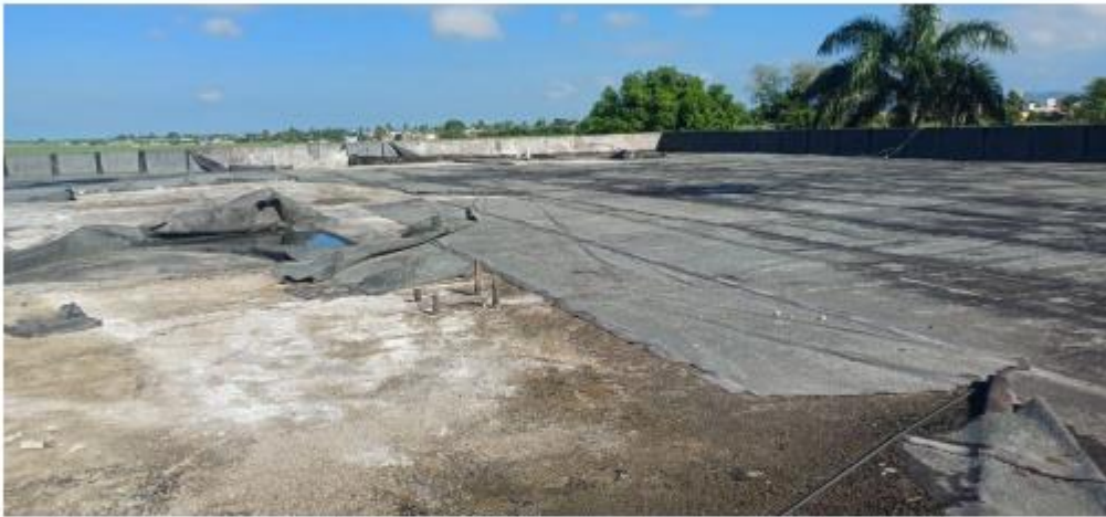
Lote 7 – Impermeabilización de techo del Juzgado de Paz de Guaymate.
