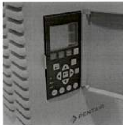
Variador de frecuencia marca Pentair
