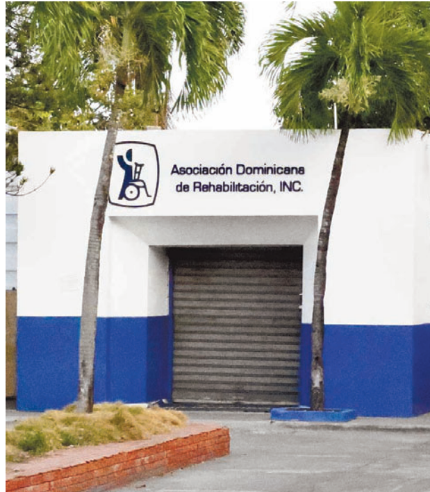
Edificio donde ocurrió el accidente ayer. FRANCISCO ÁLVAREZ.
